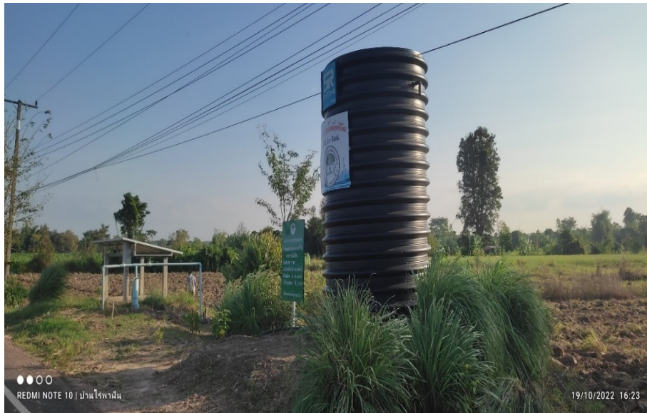
ภาพที่ ค.23 ระบบผันน้ำลงดิน ด้วยการใช้โซลาเซลล์สูบน้ำจากบ่อบาดาลมาเก็บในถัง 10,000 ลิตร ให้เกษตรกร
