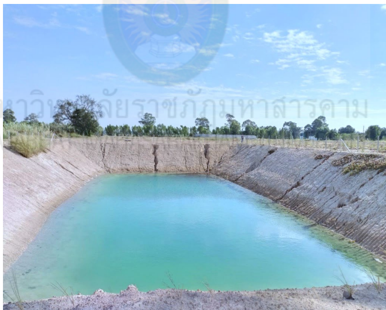
ภาพที่ 4.7 การดำเนินการธนาคารน้ำใต้ดินระบบเปิด
