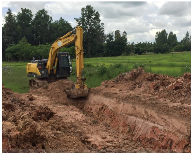
ภาพที่ 4.14 ดำเนินการขุดลอกธนาคารน้ำใต้ดินแบบเปิด
