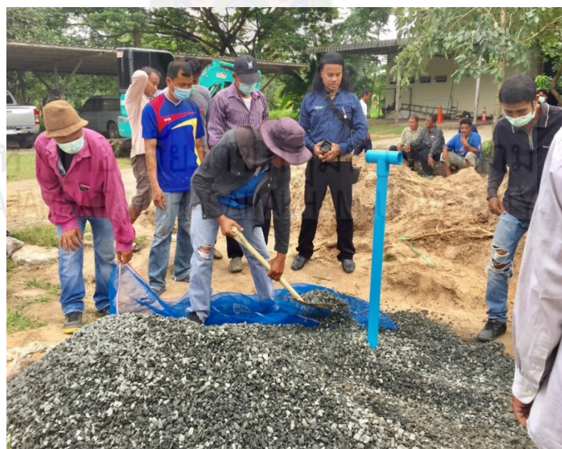
ภาพที่ 4.5 การดำเนินการธนาคารน้ำใต้ดินระบบปิด
