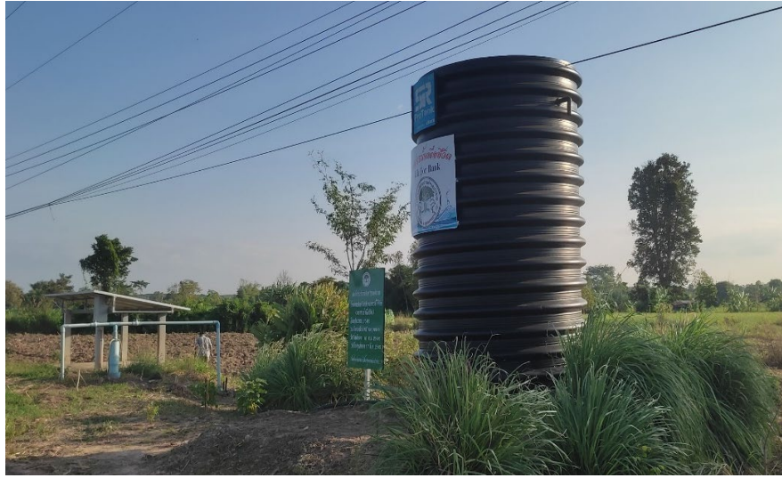
ภาพที่ 4.42 ระบบผันน้ำลงดิน ด้วยการใช้โซลาเซลล์สูบน้ำจากบ่อบาดาลมาเก็บในถัง 10,000 ลิตร ให้เกษตรกร
