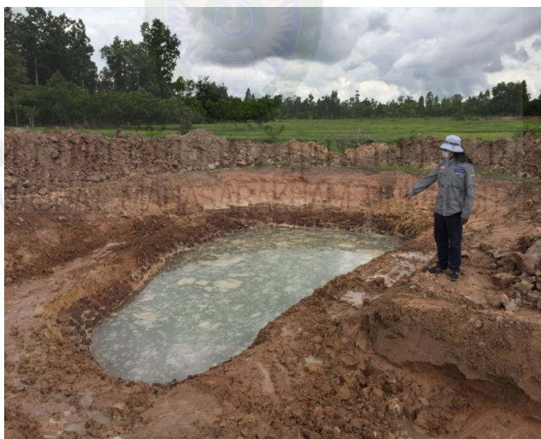
ภาพที่ 4.15 บริเวณที่ขุดลอกเสร็จธนาคารน้ำใต้ดินแบบเปิด
