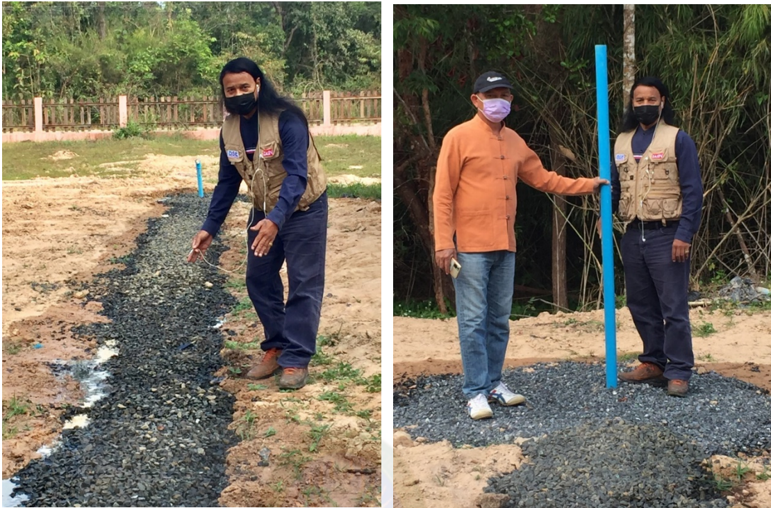
ภาพที่ ค.19 นวัตกรรมธนาคารน้ำใต้ดินระบบรางไรท่อ
