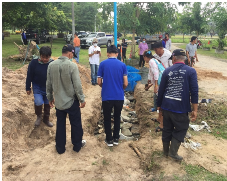
ภาพที่ 4.4 การดำเนินการธนาคารน้ำใต้ดินระบบปิด
