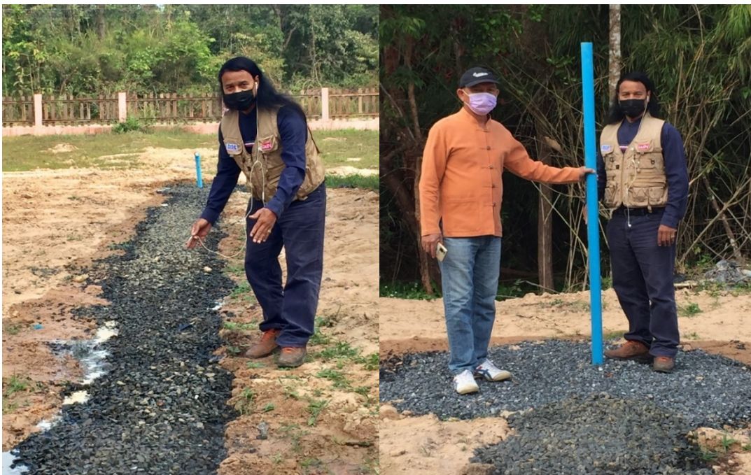
ภาพที่ 4.38 นวัตกรรมธนาคารน้ำใต้ดินระบบรางไรท่อ
