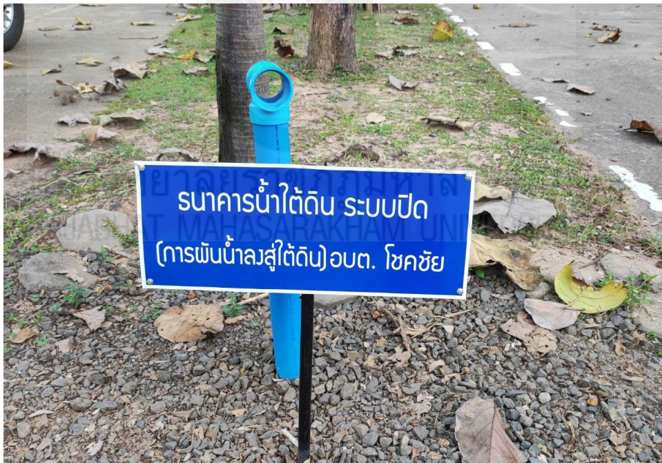
ภาพที่ ค.16 ธนาคารน้ำใต้ดินระบบปิด (การพื้่นน้ำลงสู่ใต้ดิน)
