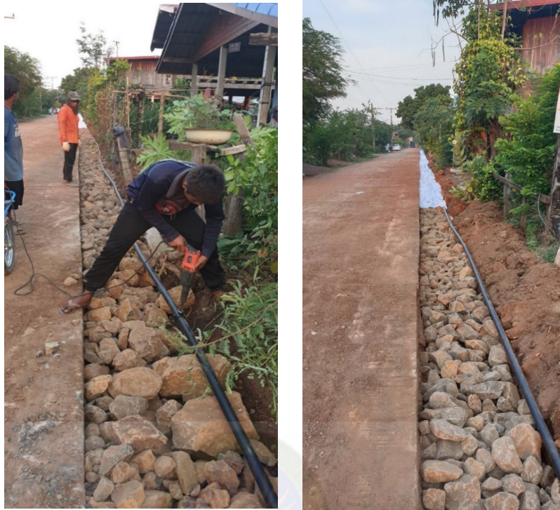
ภาพที่ ค.7 ผู้วิจัยลงพื้นที่จัดทำธนาคารน้ำใต้ดินแบบปิดในเขตชุมชน
