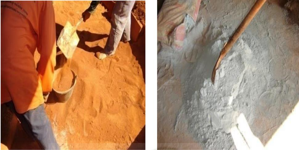
ภาพที่ ก-3 เตรียมวัสดุดิบที่จะนำมาทำอิฐมอญซีเมนต์ ดินแดง และปูนซีเมนต์
