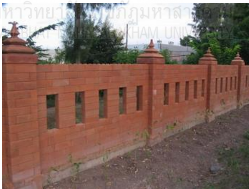
ภาพที่ 2.1 การใช้อิฐบล็อกประสานในการก่อสร้าง
