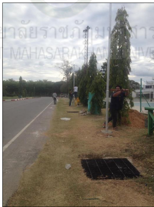
การลงเสาไฟฟ้าติดตั้งเสาไฟบริเวณข้างสนามอธุนปริทัศน์
