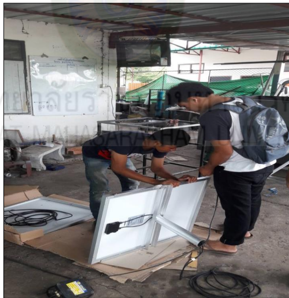
การประกอบแผงโซล่าเซลล์ใส่โครงเหล็ก
