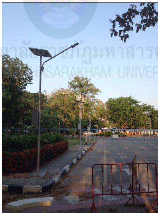
ติดตั้งเสร็จ
