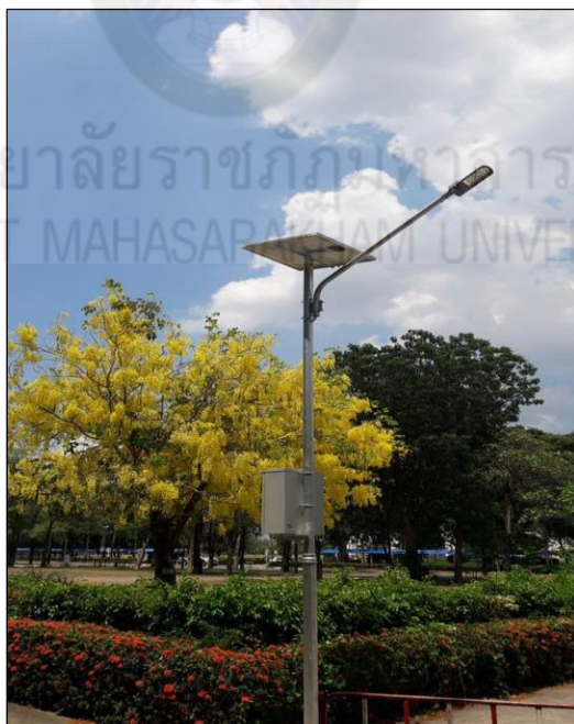
ติดตั้งเสาไฟฟ้า
