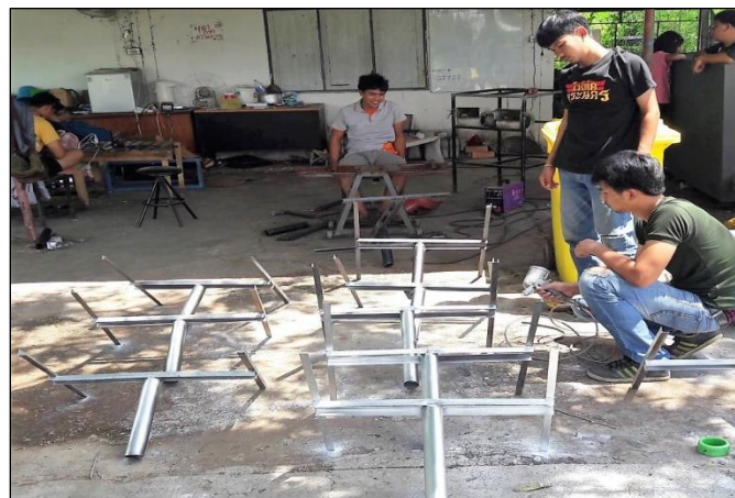
การเตรียมโครงเหล็กแผงโซล่าเซลล์
