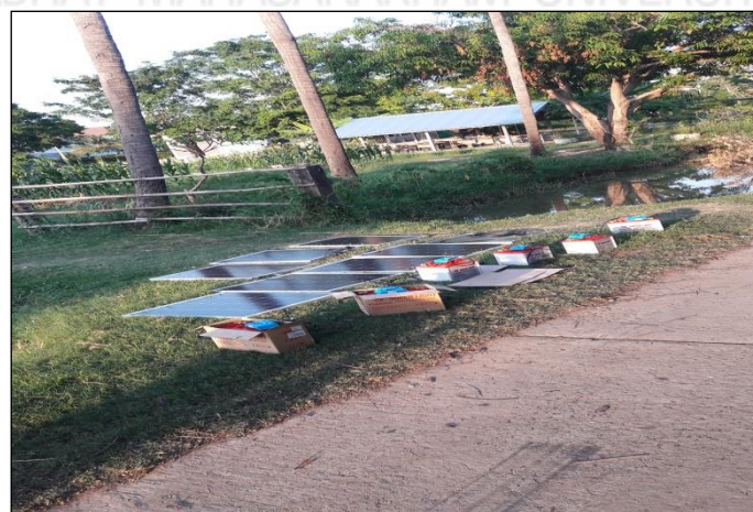
การประกอบแผงโซล่าเซลล์ใส่โครงเหล็ก
