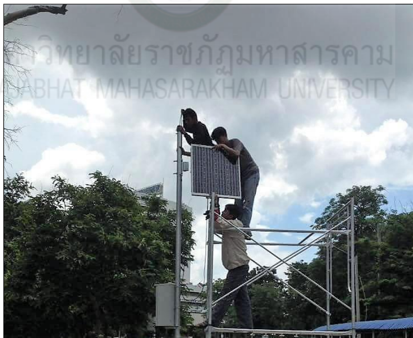
การลงเสาไฟฟ้าติดตั้งเสาไฟ
