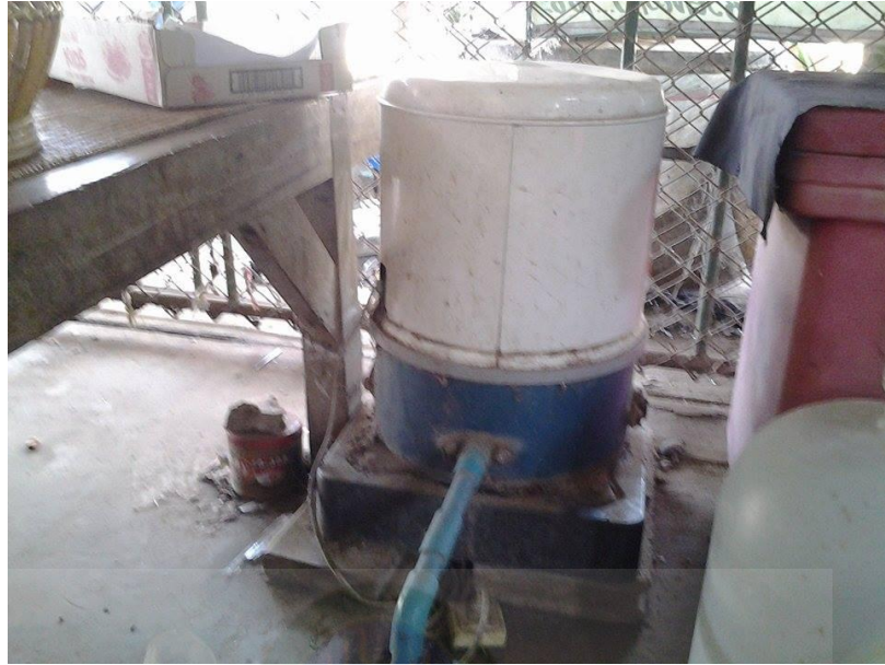
รูปที่ จ-3 รูปแสดงบ่อน้ำตื้น ที่ 9 หมู่ 15 บ้านคอกม้า ต.โคกพระ
