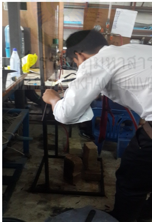
รูปที่ ค-8 การเชื่อมต่อทองแดงกับชุดวาล์วควบคุมการเติมสารทำงาน
