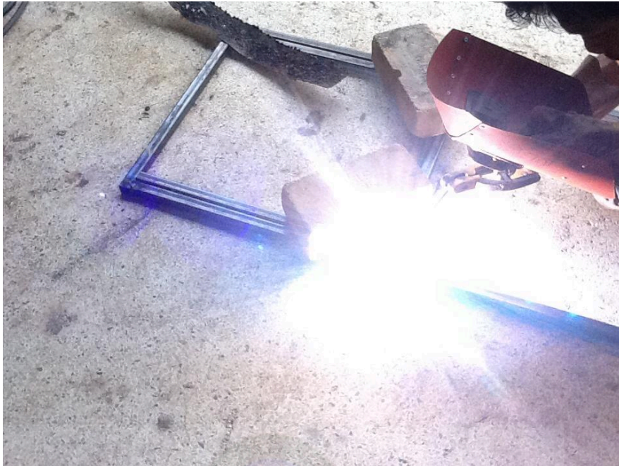
รูปที่ ค-7 การเชื่อมโครงเหล็กเพื่อสร้างชุดเติมสารทำงาน
