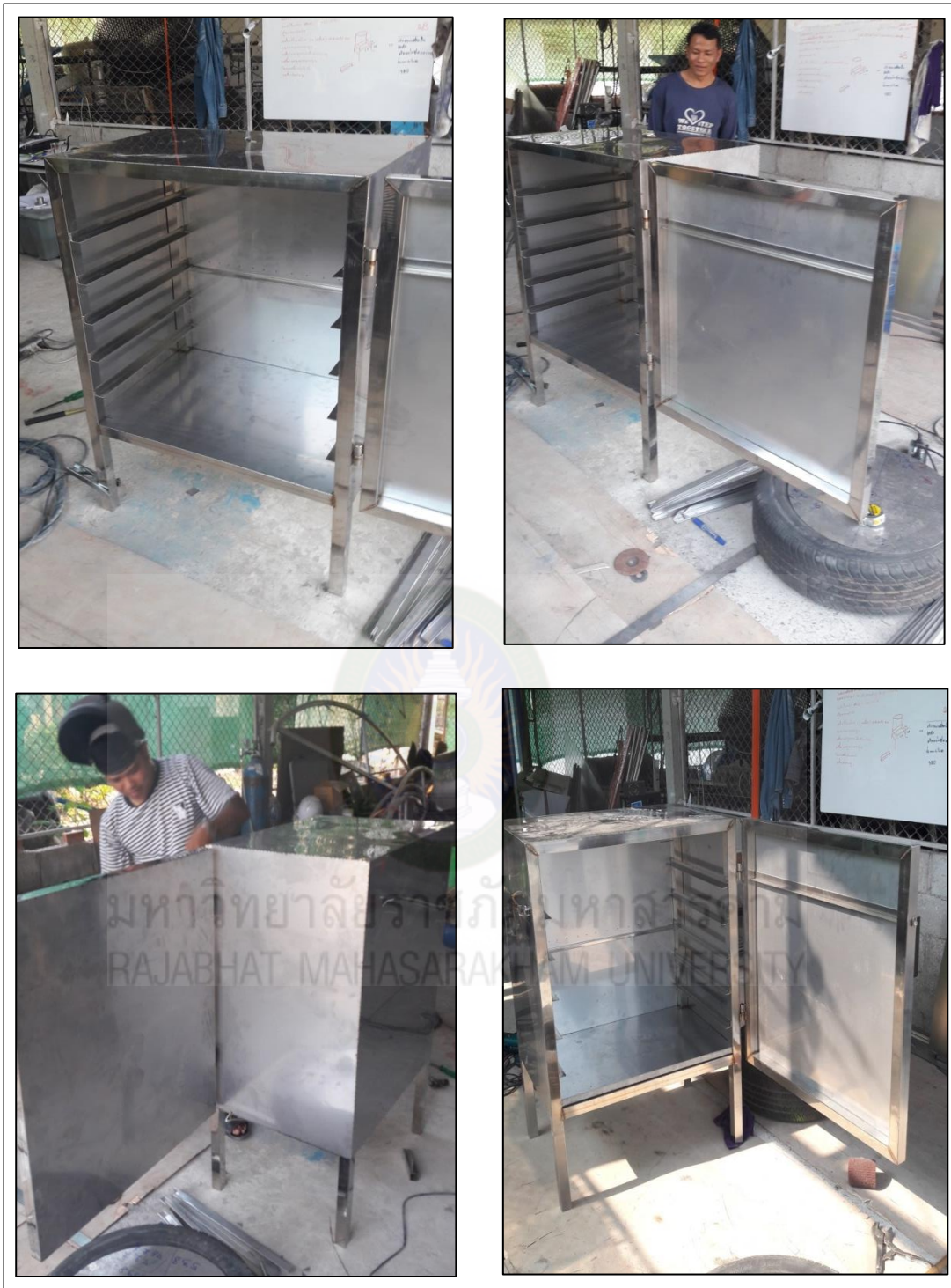
ภาพที่ ข-1.3 การดำเนินการประกอบตู้ควบคุมความชื้น
