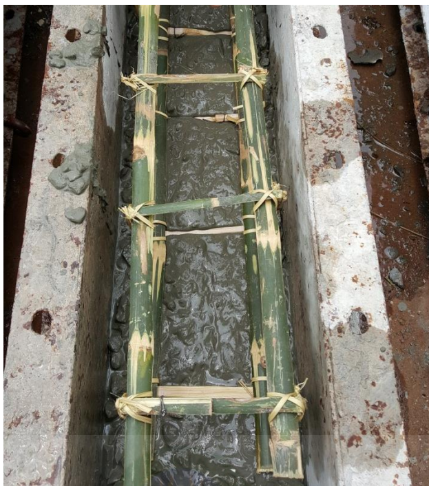
ภาพประกอบที่ 36 การหล่อตัวอย่างเสาคอนกรีต
