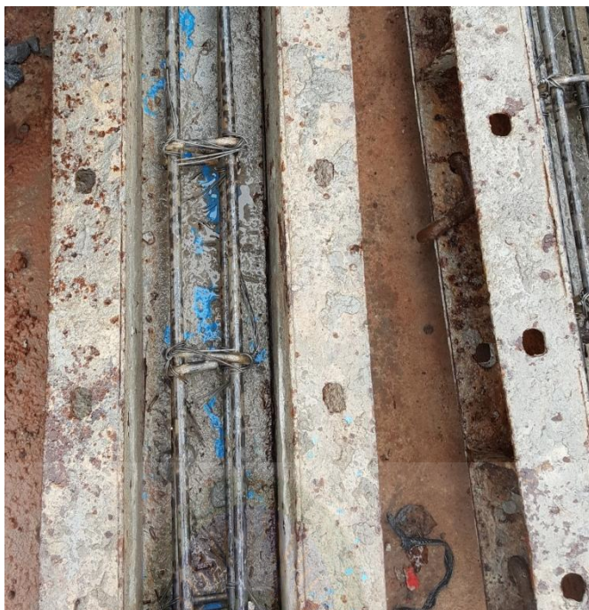
ภาพประกอบที่ 34 การหล่อตัวอย่างเสาคอนกรีต
