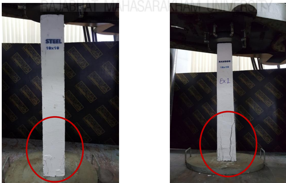
ภาพประกอบที่ 24 รูปแบบการวิบัติของเสาคอนกรีต ขนาด 10x10 เซนติเมตร
