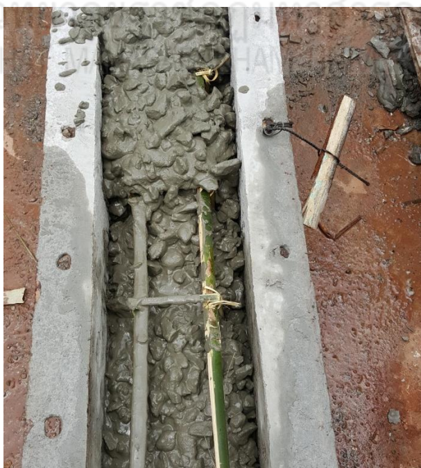
ภาพประกอบที่ 35 การหล่อตัวอย่างเสาคอนกรีต
