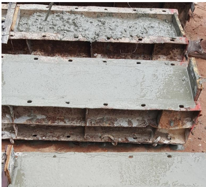
ภาพประกอบที่ 38 การหล่อตัวอย่างเสาคอนกรีต
