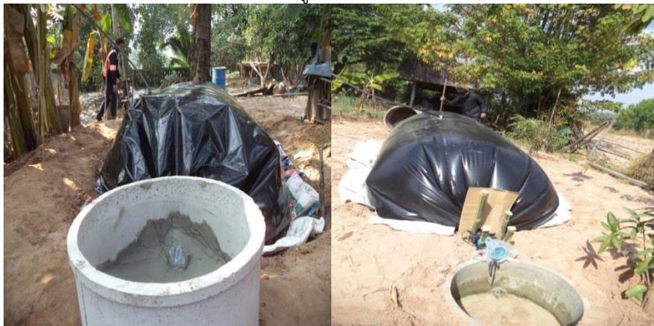
รูปที่ 3.23 ทำบ่อล้นและบ่อเติม
