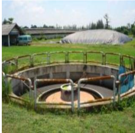
รูปที่ 2.11 บ่อหมักแบบ UASB ที่มา : (เค.พี.แอล.เวิร์ลด์เทรคดิง, 2014) product/biogas-bag/
