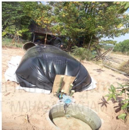
รูปที่ 2.8 บ่อหมักก๊าซชีวภาพแบบถุง LDPE
