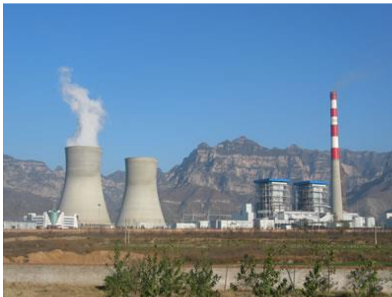
รูปที่ 2.17 โรงไฟฟ้าพลังงานความร้อน
