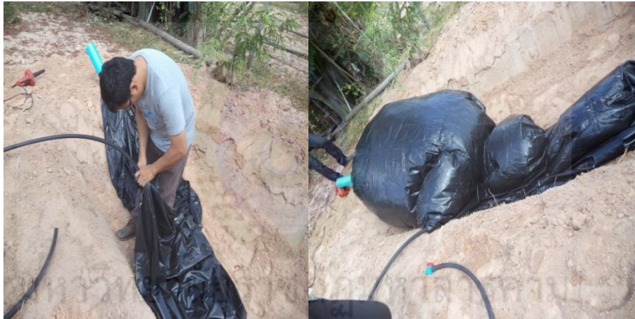
รูปที่ 3.22 วางถุงหมักในบ่อที่เตรียมไว้
