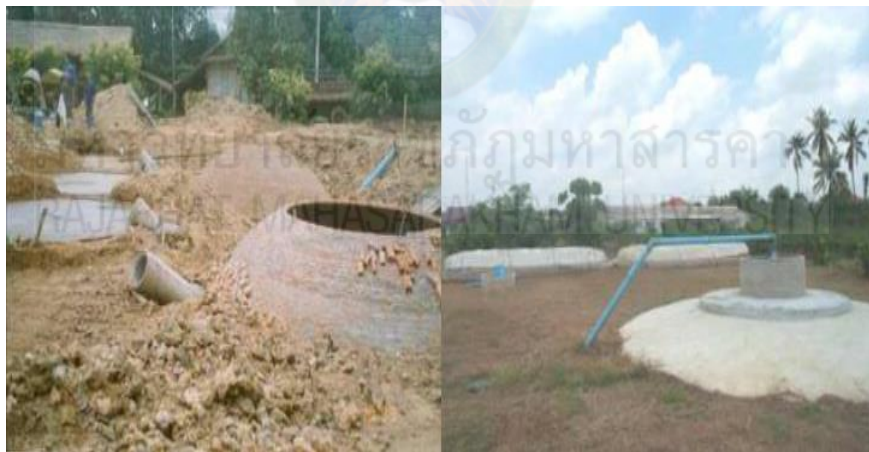
รูปที่ 2.6 บ่อหมักข้าวแบบโดมคงที่ (Fixed dome digester)
