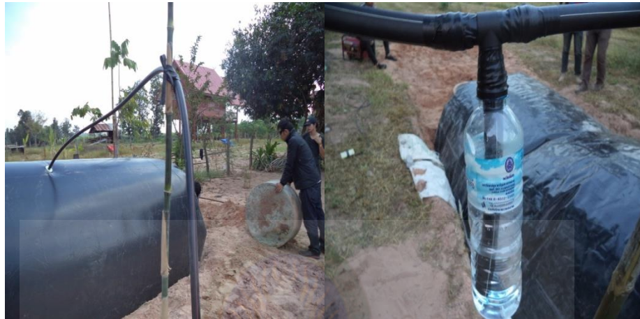
รูปที่ 3.24 ประกอบสายส่งก๊าซและขวดปรับแรงดัน
