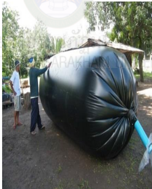
รูปที่ ข - 4 มัดถุงพลาสติกพีวีซีกับท่อพีวีซี
