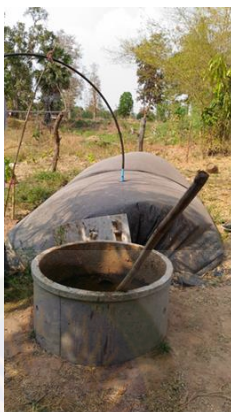
รูปที่ ก - 1 บ่อหมักแบบพลาสติกพีวีซีขนาด 8 ลูกบาศก์เมตร
