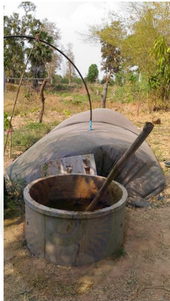
รูปที่ 4.1 บ่อหมักแบบพลาสติกแอลดีพีอีปริมาตร 8 ลูกบาศก์เมตร
