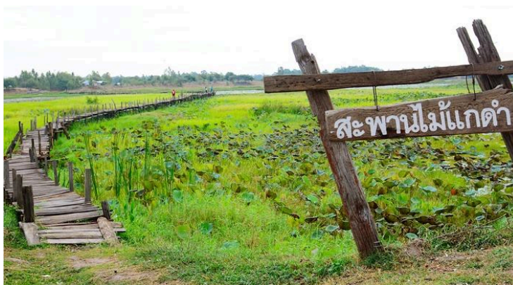
ภาพที่ 2.14 สะพานไม้แกดำ
