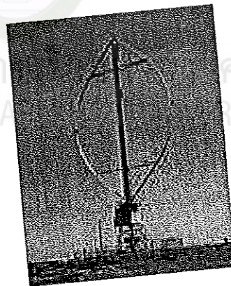
รูปที่ 2.7 กังหันลมแนวแกนตั้ง ที่มา (นร.ปรีชญ์ พรหมรักษ์และคณะ, หน้า 4)
