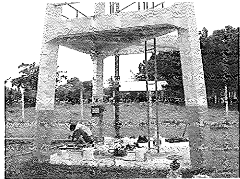
การติดตั้งกังหันชุดที่ 3
