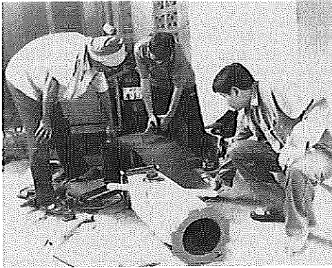
การขึ้น โครงกลองเพื่อกันน้ำเข้าสู่ระบบภายใน
