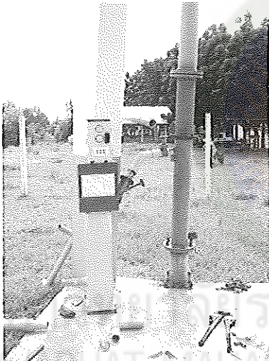
ติดตั้งกังหันชุดที่ 3 เสร็จสมบูรณ์
